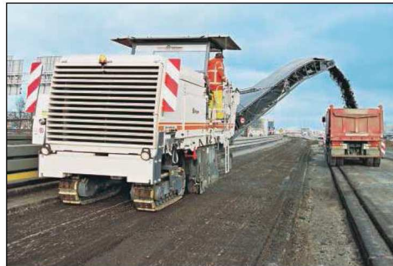
Slika 2.15: Pridobivanje asfaltnega rezkanca z rezkarjem
